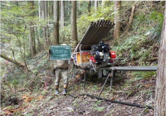
民地でのモノレール設置
