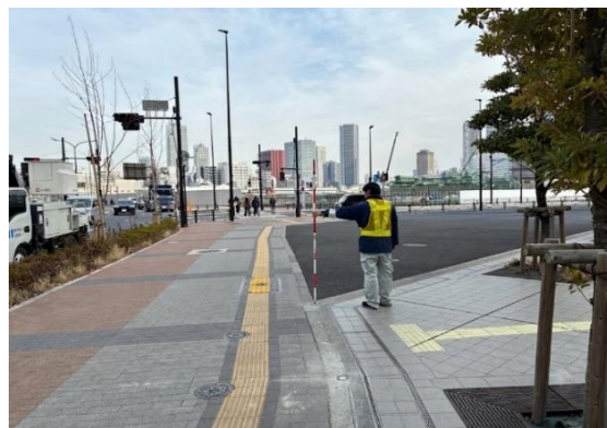
新大橋通りとの交差点付近での境界点測量
