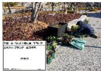
設置作業中の様子
