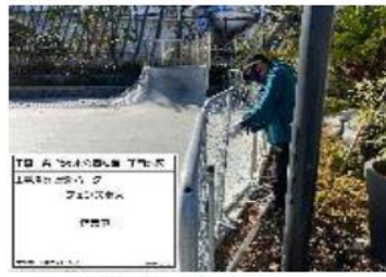
設置物は正作業中の様子
