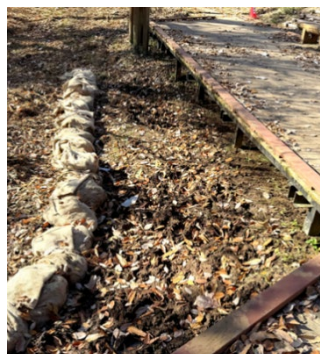
土壌で作業エリア準備
