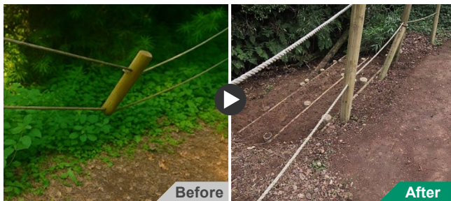
崩れた斜面を強固に補修し安全を確保
