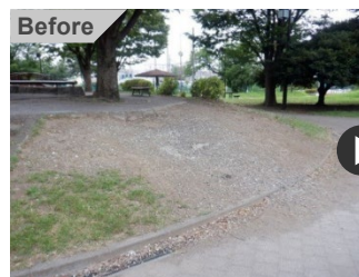
裸地化した法面（施工前）
