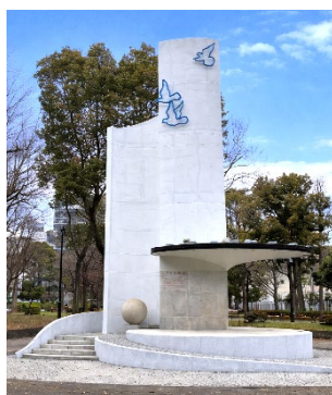
リニューアル塗装したこども平和塔
