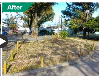
法面緑化とロープ柵設置（施工後）
