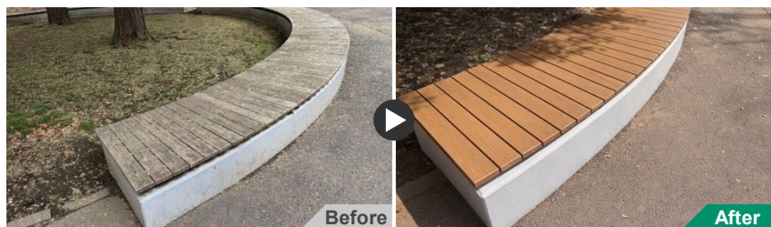
塗装をし、来園者の滞在性と景観が向上したベンチ
