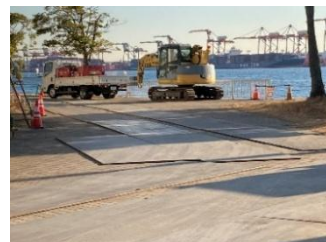
公園南側護岸工事
