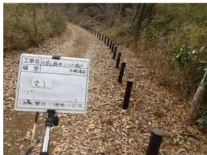
① 二つ池～尾根道 ロープ柵修繕
