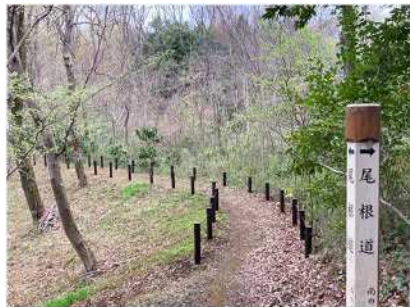
② 藤の宮口 ロープ柵修繕
