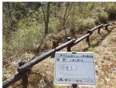
③ 尾根道沿い 木柵修繕
