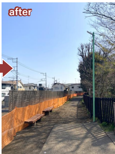
作業時には反対行動があったが、適切な対応で伐採を実施
