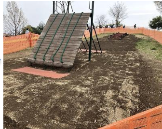
下地処理後に土入れ、芝張り施工
