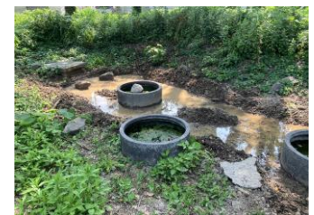
水漏れ箇所を修復しながら貯水
