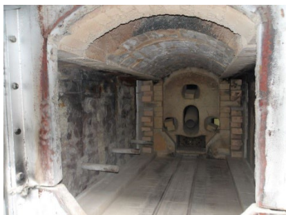
火葬炉耐火レンガ補修
