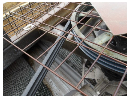
空調機器の部品修繕（冷却塔ファン）
