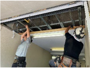
電動シャッター取替工事
