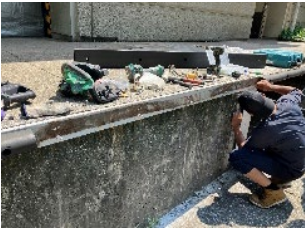
搬入口カーストッパー 補修工事
