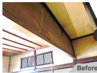
ひびが入って、壁から浮き上がっていた壁紙を修復し、往時の姿を取り戻す
