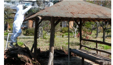
四阿屋根のアスベスト含有資材を適切に撤去
