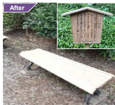
ベンチは再塗装、部材交換、解説版は研磨して再塗装し、観賞環境を向上
