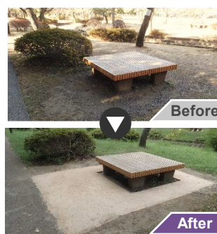
縁台下の舗装
