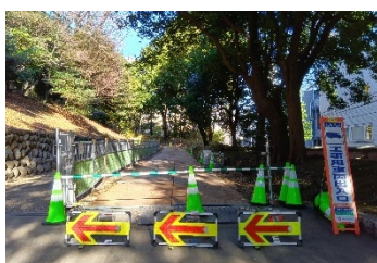
毎日閉所後、火事など夜間緊急車両入場に備えて職員で工事通路を開放
