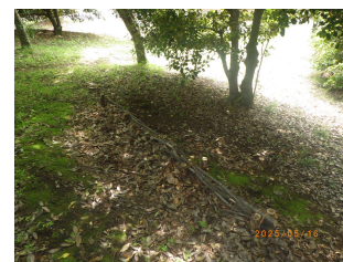
粗朶柵の設置・補修
