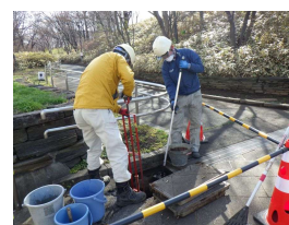
有孔管の高圧洗浄
