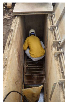
北側処理施設高圧洗浄
