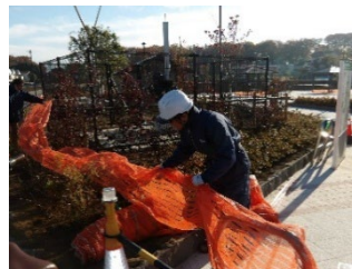
仮設物の撤去
