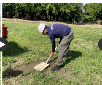
整正、金属探知機で鉄杭回収
