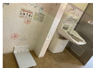
フィッシングボードを新設
