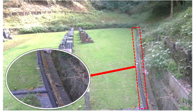
副側溝工法（赤丸）により通水性が良くなった
