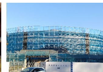
閉鎖され足場が組まれたみたま堂
