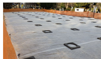
凍結防止のため張芝に養生を行う
