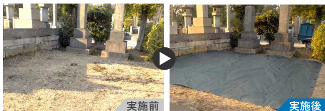
空き墓所に防草シートを設置
