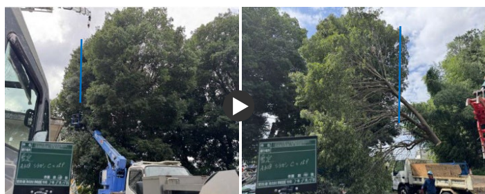
2台のクレーンを使用し、安全に危険樹木を処理
