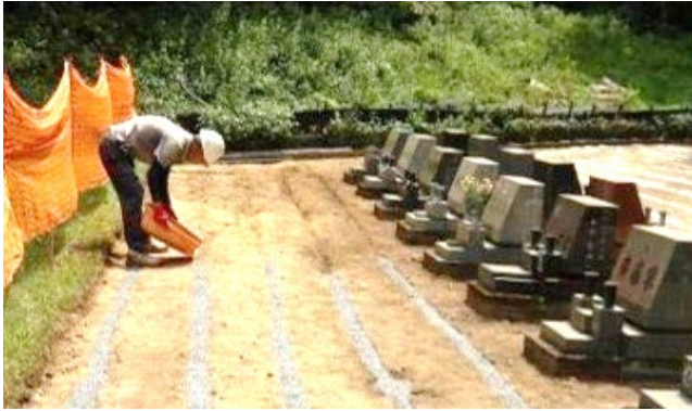
ターフリフレッシュ施工時
