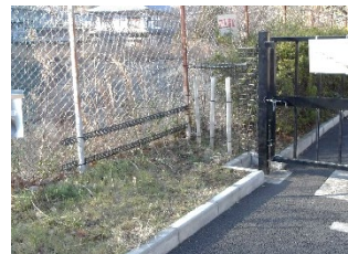
夜間は門を閉鎖して侵入口を断つ
