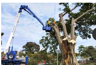
高所作業車を使用した作業状況
