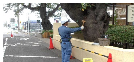
樹木点検の様子
