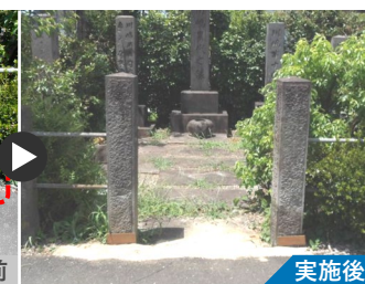
隙間に防草砂を施工
