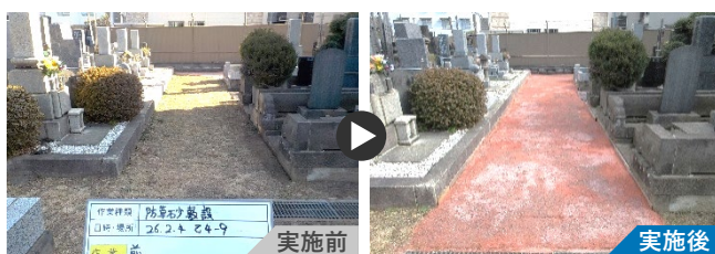
園路に防草砂を敷設
