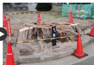
伐採後の切株と保安状況
