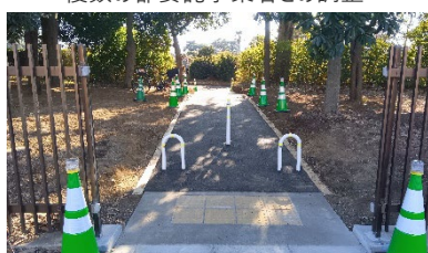
事故予防のため、LED灯コーンを設置
