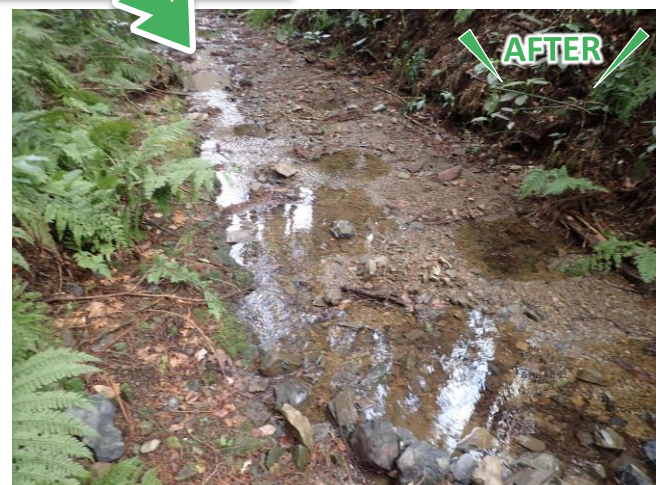
←埋まってしまった水路 ↓掘削により再び流れが復活！
