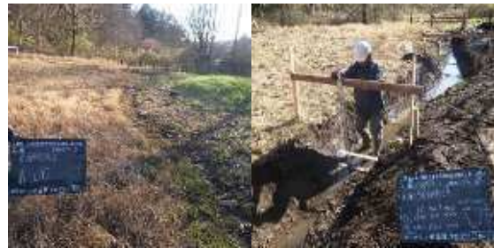
写真 13, 14 整備前(左)、整備後(右)
