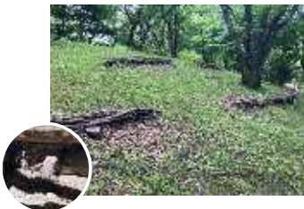
写真1 粗朶柵設置箇所
