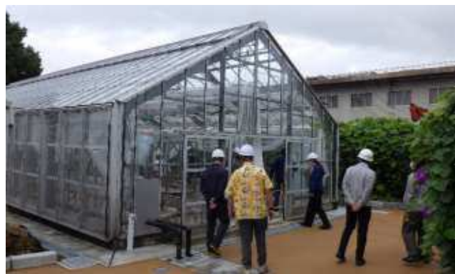
写真 18 栽培温室 B 改修工事（都工事）
