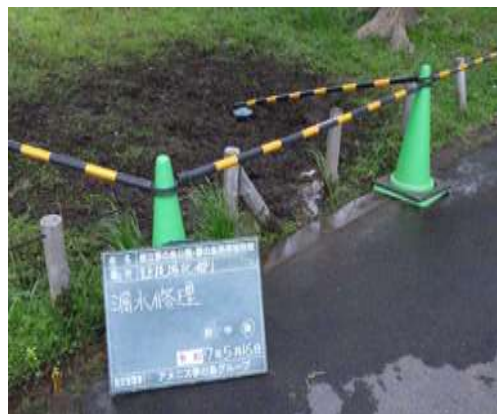
写真6 競技場横漏水補修
