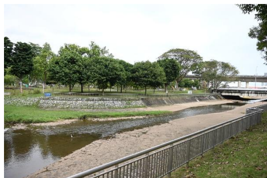
写真6 カラン川下流側（改修前の河川の 護岸の様子が見える）
