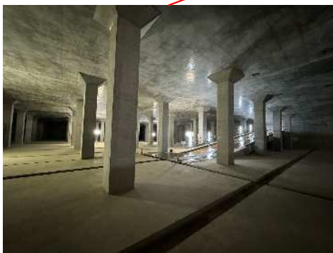
下高井戸調節池
