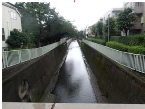
番屋橋下流(杉並区)
