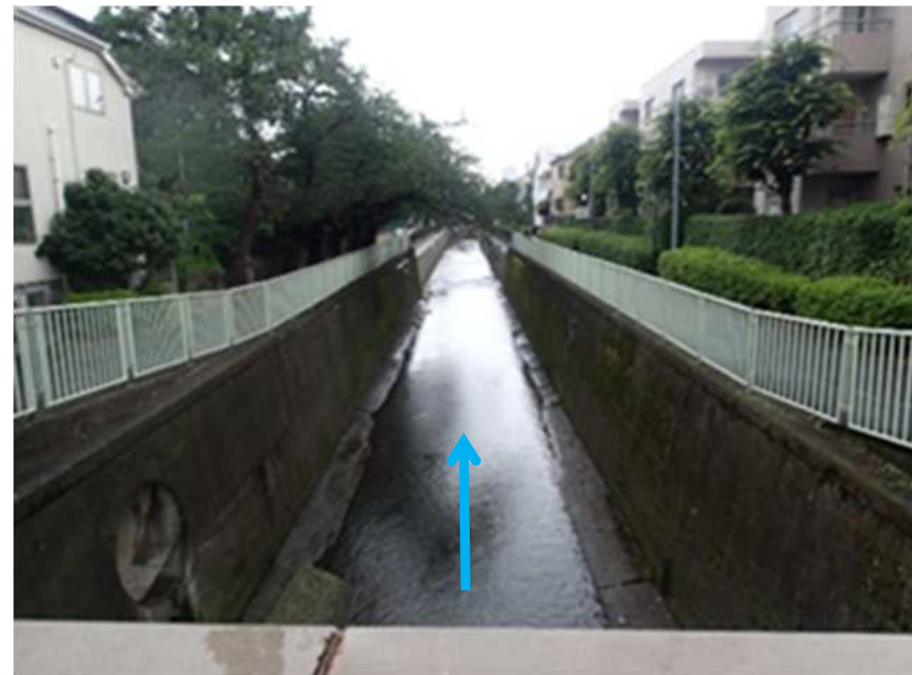
護岸整備予定箇所（番屋橋下流）
