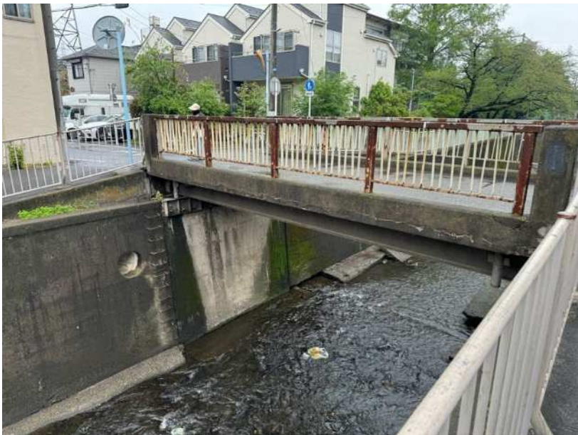
架替予定橋梁（番屋橋）
