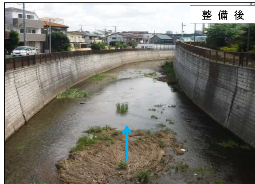
河道拡幅による流下能力の向上
