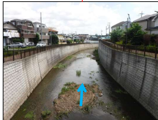
あたご 愛宕橋下流側
