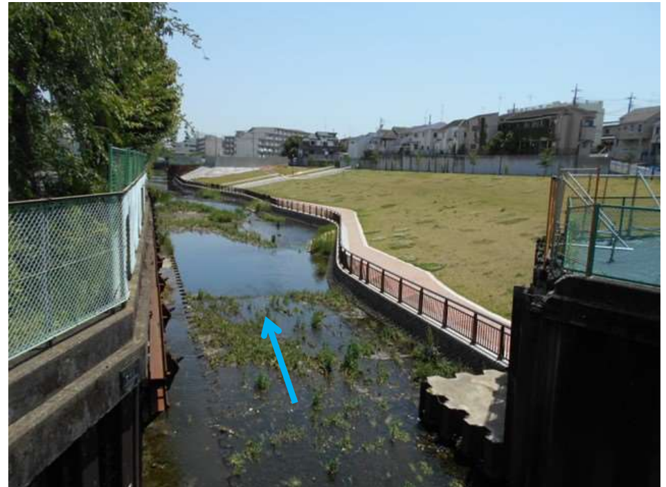
右岸整備後(左岸も今後整備予定)
