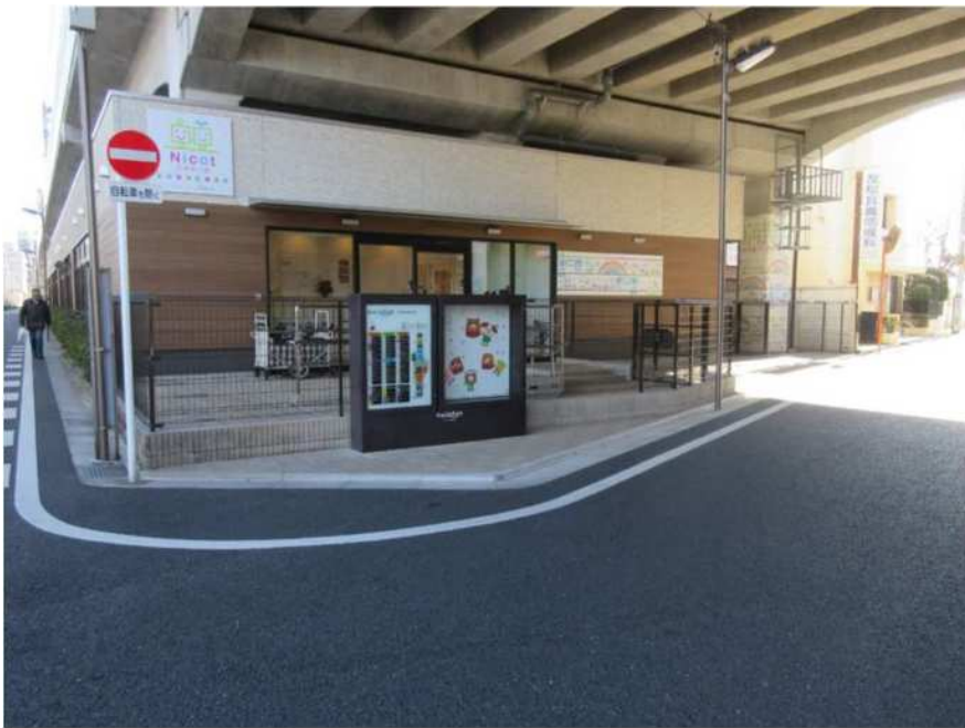
(例) 高架下を利用した保育園(石神井公園付近)
