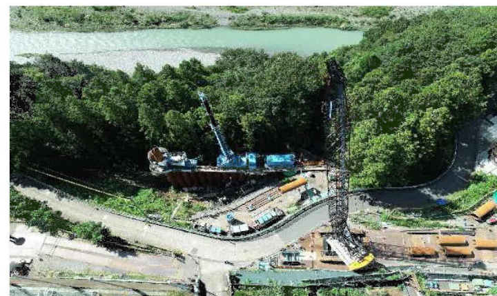
施工中の航空写真。市道を供用しつつ、狭いヤードに資機材の配置を工夫して工事を進めた。
