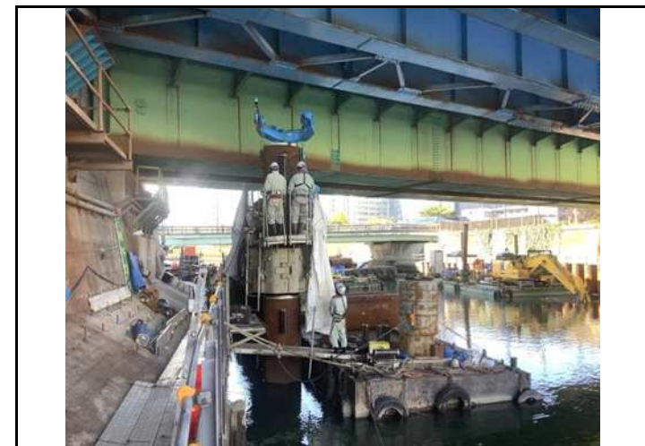
鋼管矢板圧入状況（鉄道桁下部）
