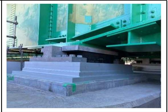
施工後（支承取替完了）
