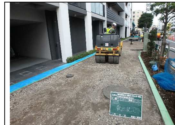
民地への汚れ飛散防止養生状況 （地先に説明を行い、了解のうえ実施）
