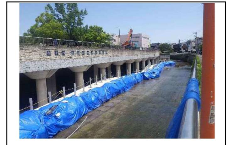
増水に対する施工中の止水状況
