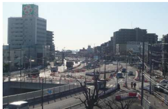
交通切替（暫定形）の実施後の状況 （トンネル両側に設けた側道へ切替）
