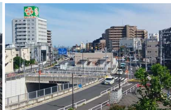
電気室等設備関連工事の完了後の状況
