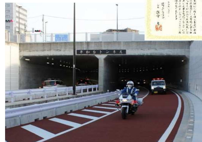
放35平和台トンネル暫定開通の様子（令和6年2月）
