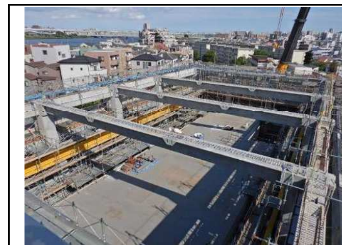
PCaPC部材架設状況
