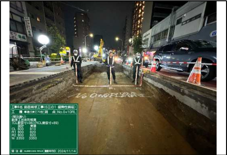
車道舗装工（全断面打換え）
