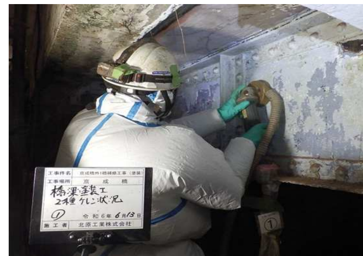
特殊作業着を着用しての作業
