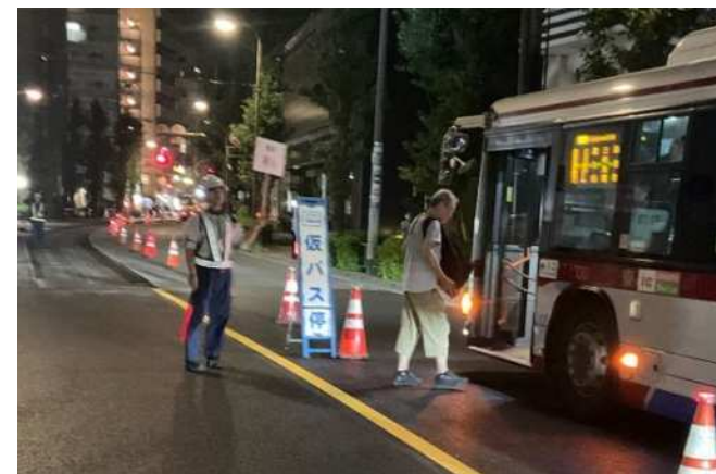
仮バス停設置時におけるバス利用者の乗降車誘導状況
