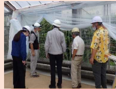
栽培温室B竣工検査立会
