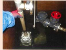
大温室流れポンプ工事
