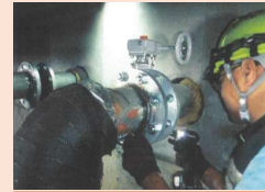
大温室温水管 ハンドルバルブ新設工事
