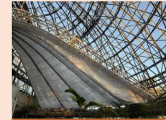
イベントホールテント 稼働ワイヤー交換工事
