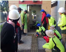
防災トイレ設置訓練
