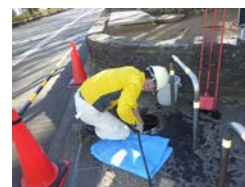
有孔管の高圧洗浄
