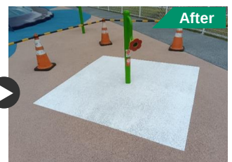
施工後（遮熱塗料塗布）
