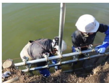
浮間ヶ池の護岸修復作業
