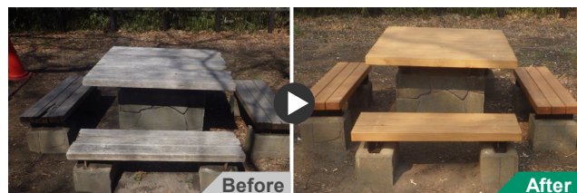
野外卓（施工前）
