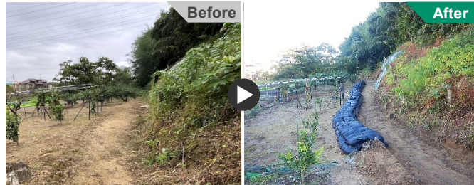
畑側への土砂流入を防止するため仮設土のうを設置し大雨に備えた
