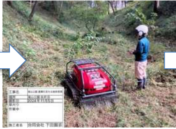
ラジコン式草刈機で 急斜面も安全に作業
