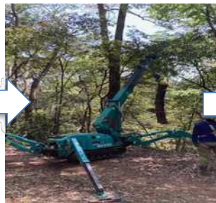
他の木に複雑にかかっている 場合などスパイダーリフト により安全に伐採した。
