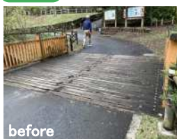
before 腐食が進んだ木部交換を実施
