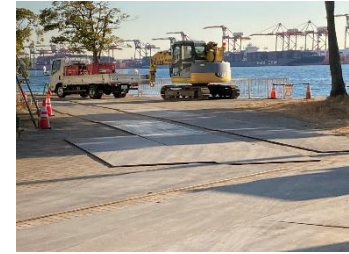
公園南側護岸工事
