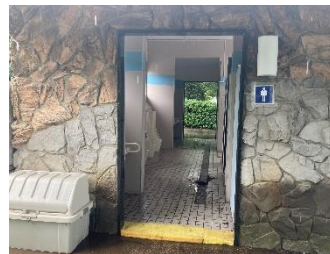
トイレ雨水流入防止措置
