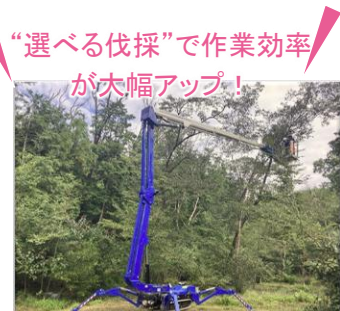
スパイダーリフトで伐採
