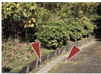
側溝沿いの草刈りにより排水機能を維持
