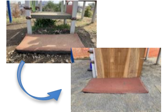
ゴムマット段差解消
