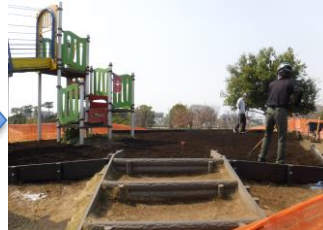
盛土工事（改修中）
