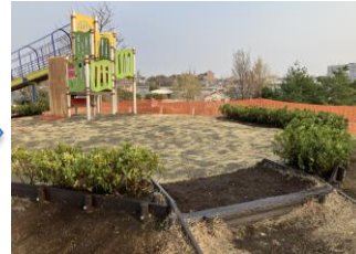
土留めを低木で囲い芝生を造成（改修後）
