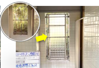
窓枠に波板を取り付け保護
