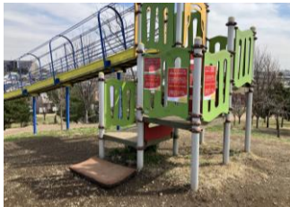
土が削られた山頂部（改修前）
