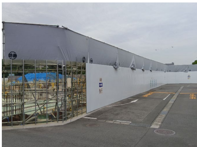
解体工事時の防音・粉じん対策
