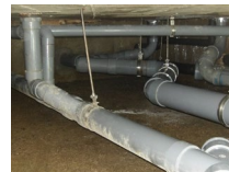
汚水配管取替工事
