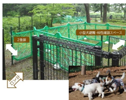
仮設フェンスなどの設置状況
