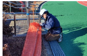
仮設撤去状況
