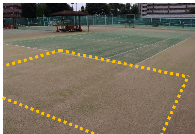
修復後の沈下箇所
