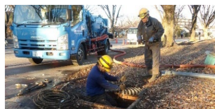
根の除去作業
