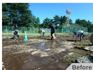
会場資機材の撤収作業直後 (養生敷設により芝が枯れた)
