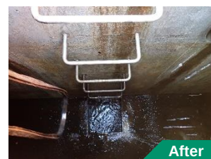
排水によりピット機能を維持
