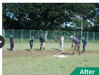
直営で応急処置 (砂入れによる不陸整正)
