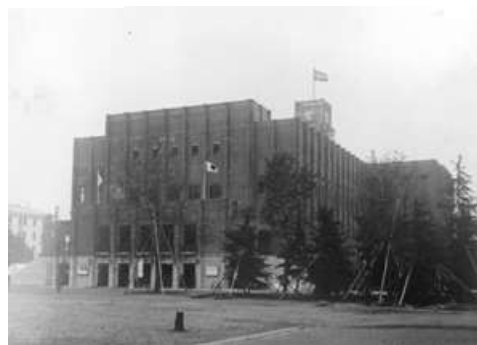
図 4-4 竣工時写真（北西面）昭和 4 年頃
