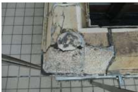
図 2-70 テラコッタ割れ補修跡
