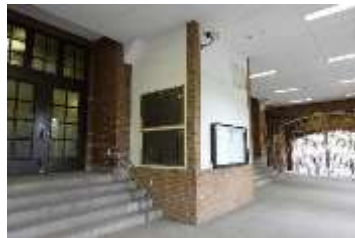
図 2-29 エレベーター（増築）
