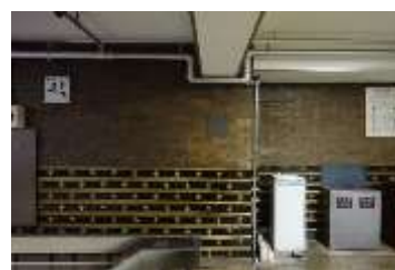
図 2-40 木製腰壁（昭和36年）
