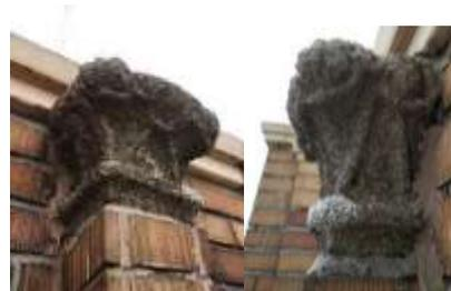
図 1-84 人造石洗出し彫刻(塔屋外部)
