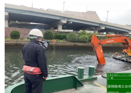
【施工状況の確認（受注者）】
