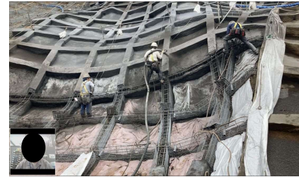
【 施工状況の確認（吹付工） 】
