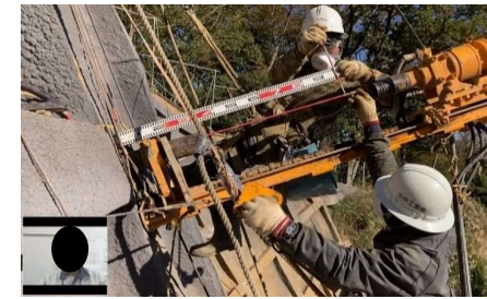
【 立会い（ロックボルト工の出来形） 】
