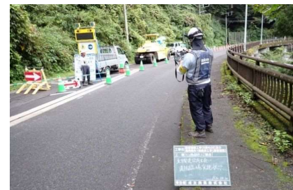
【現場状況の確認(受注者)】
