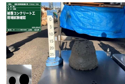
【生コン現場試験（スランプ）】
