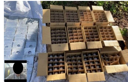
【 材料検査（ロックボルト工の材料） 】
