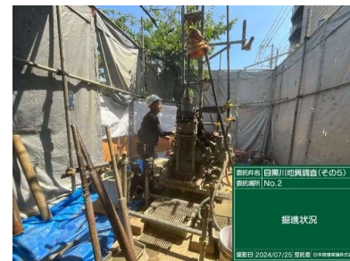
【ボーリング実施状況】
