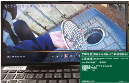
【排水目皿取替工】
