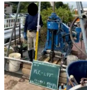
【施工状況の確認】（発注者側画面）
