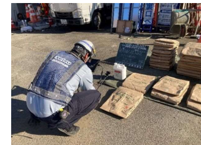
【工事材料の確認】
