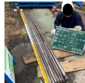
【施工状況の確認】（発注者側画面）
