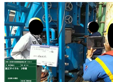
【施工サイクル確認】
