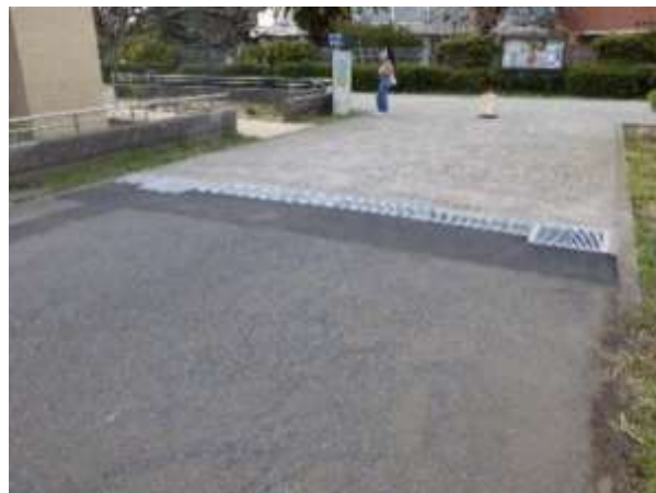
写真7 排水設備改善工事
