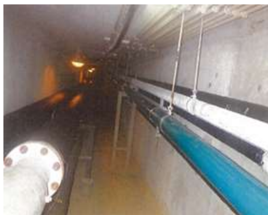
写真 20 共同溝内排水ポンプ交換
