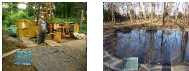
写真7 井戸設置状況
