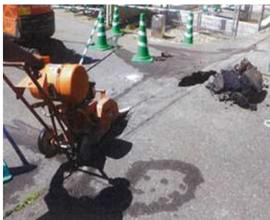
写真 18 AS 舗装陥没箇所補修
