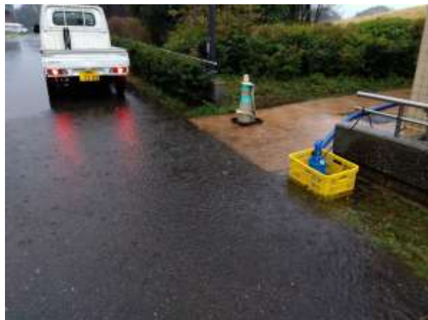
写真6 これまでの排水ポンプ対応時
