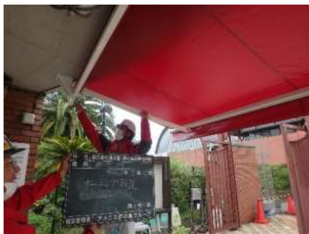
写真 27 発券機オーニング設置
