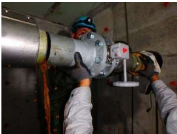
写真 28 老朽化した配管の交換（地下ピット内）
