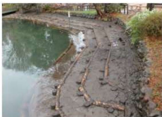
写真1 整備後の弁天池下流浅場
