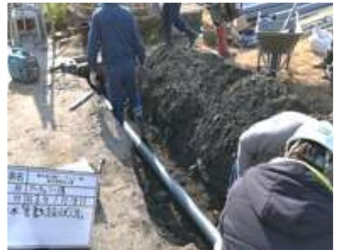
写真7 排水管交換工事
