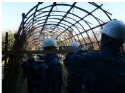
写真 23 両側の胴縁の水平を確認
