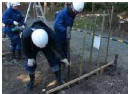
写真 18 立子設置穴を開ける
